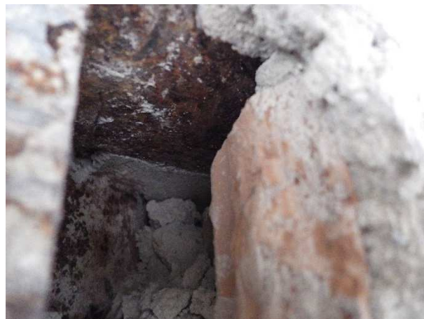
Foto č.12, 13 – sonda NS 7 – 5.NP- m.č. C518 –detaily – ocelová závlač;
