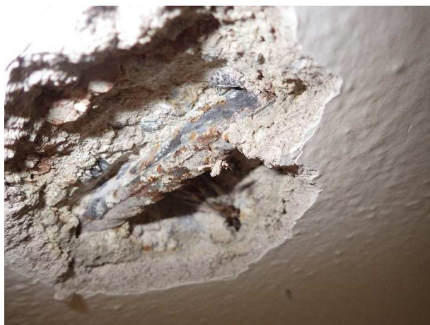
Foto č.38, 39 – sonda NV 5 – 5.NP- m.č. C518 – detail výztuže; zk. karbonatace
