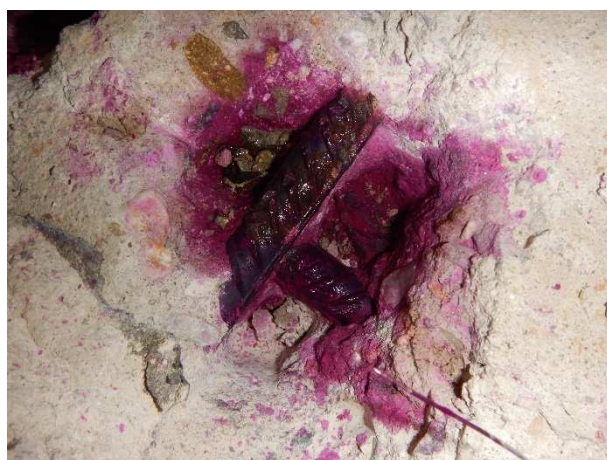
Foto č.56, 57 – sonda NV 14 – 1.NP- m.č. B106 – celkový pohled a detail výztuže; zk. karbonatace
