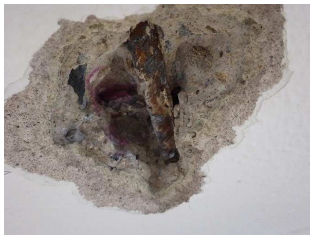
Foto č.40, 41 – sonda NV 6 – 1.NP- m.č.C122 – celkový pohled a detail výztuže; zk. karbonatace
