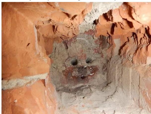
Foto č.10 – sonda NS 6 – 4.NP- m.č. C407; náhodně zjištěný otvor v plášti trubky
