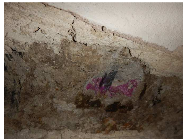
Foto č.70, 71 – sonda NV 22 – 1.PP- m.č. B007 – celkový pohled a detail výztuže; zk. karbonatace
