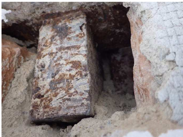
Foto č.12, 13 – sonda NS 7 – 5.NP- m.č. C518 –detaily – ocelová závlač;
