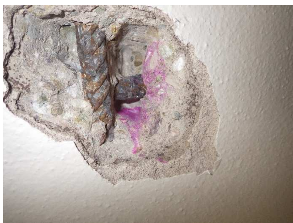
Foto č.32, 33 – sonda NV 2 – 1.PP- m.č. C027- celkový pohled a detail výztuže; zk. karbonatace
