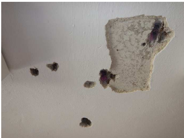
Foto č.58, 59 – sonda NV 15 – 2.NP- m.č. B204 – celkový pohled a detail výztuže; zk. karbonatace
