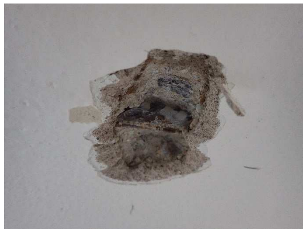
Foto č.42, 43 – sonda NV 7 – 5.NP- m.č. C518 – celkový pohled a detail výztuže;
