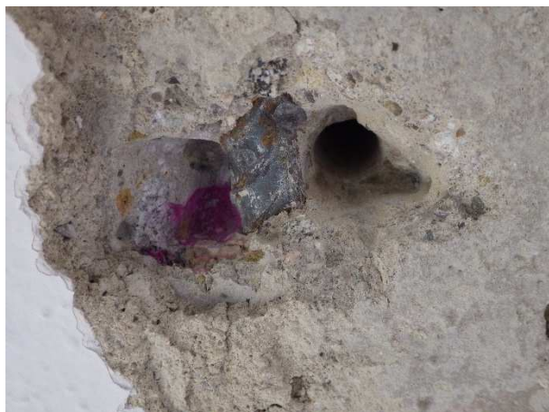
Foto č.66, 67 – sonda NV 20 – 2.NP- m.č. B209 –detail výztuží; zk. karbonatace
