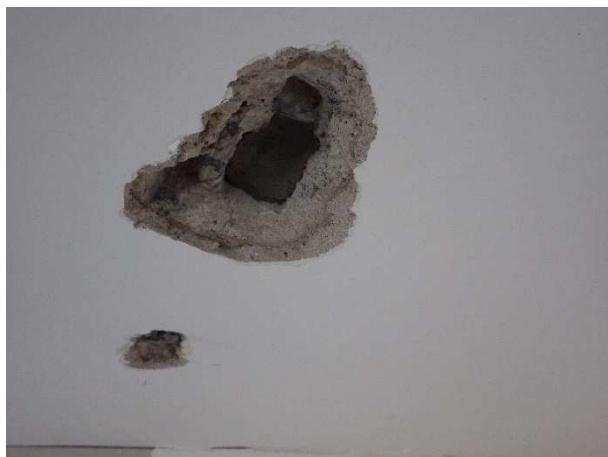
Foto č.42, 43 – sonda NV 7 – 5.NP- m.č. C518 – celkový pohled a detail výztuže;
