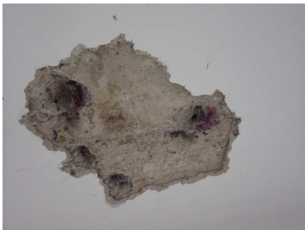
Foto č.36, 37 – sonda NV 4 – 4.NP- m.č.C416 – celkový pohled a detail výztuže; zk. karbonatace
