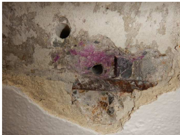
Foto č.58, 59 – sonda NV 15 – 2.NP- m.č. B204 – celkový pohled a detail výztuže; zk. karbonatace
