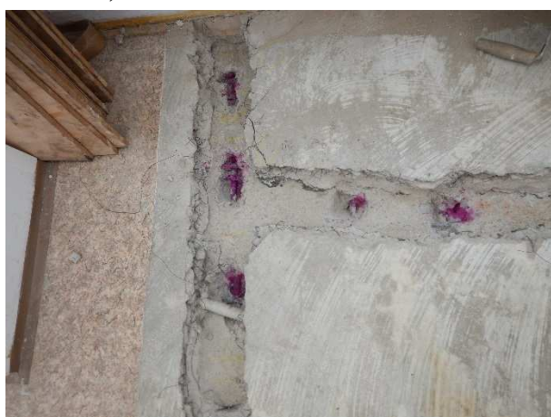
Foto č.44, 45 – sonda NV 8 – 4.NP- m.č. C416 – celkový pohled a detail výztuže; zk. karbonatace
