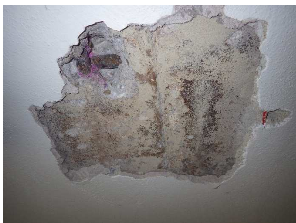
Foto č.32, 33 – sonda NV 2 – 1.PP- m.č. C027- celkový pohled a detail výztuže; zk. karbonatace
