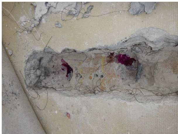
Foto č.54, 55 – sonda NV 13 – 1.NP- m.č. B106 – celkový pohled a detail výztuže; zk. karbonatace
