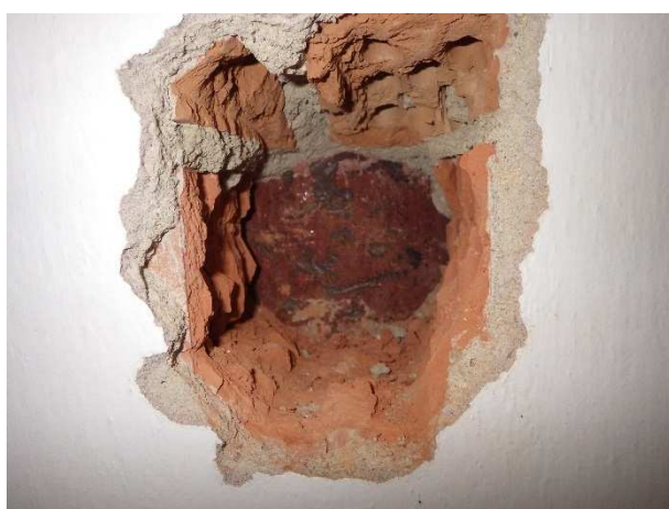
Foto č.10 – sonda NS 6 – 4.NP- m.č. C407; náhodně zjištěný otvor v plášti trubky
