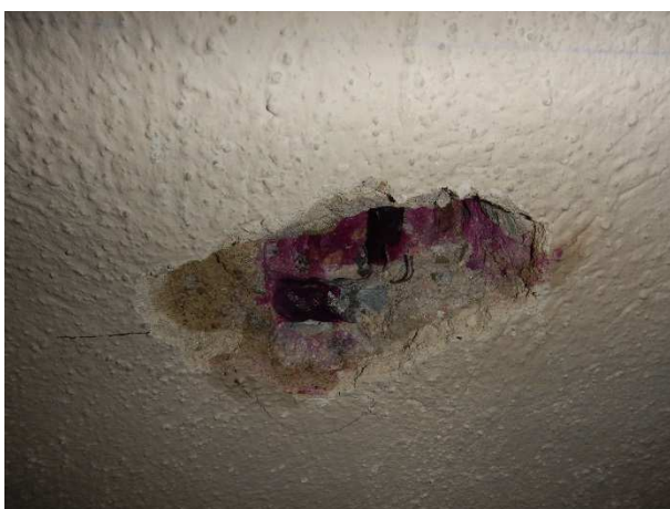
Foto č.74, 75 – sonda NV 24 – 1.PP- m.č. B007 – celkový pohled a detail výztuže; zk. karbonatace
