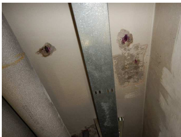
Foto č.68, 69 – sonda NV 21 – 1.PP- m.č. B007 – celkový pohled a detail výztuže; zk. karbonatace
